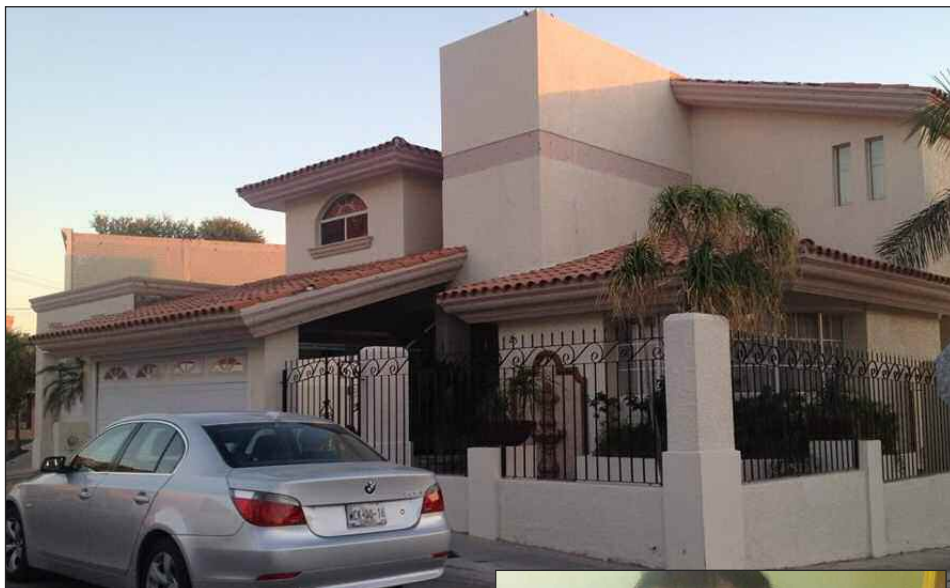
BMW y Mansión de Juventino Jiménez ubicado en Calle Inglaterra No. 25 en Residencial Bretaña.
